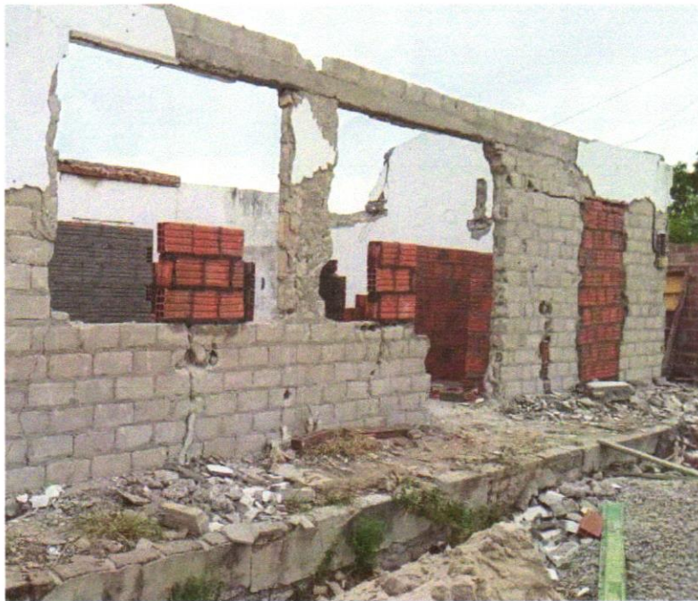
FOTO 07 – - ALVENARIA DE VEDAÇÃO DE BLOCOS CERÂMICOS FURADOS NA HORIZONTAL DE 9X19X29 CM (ESPESSURA 9 CM) E ARGAMASSA DE ASSENTAMENTO COM PREPARO EM BETONEIRA. AF_12/2021
