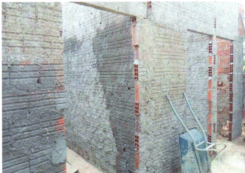
Foto 08 - VERGA PRÉ-MOLDADA PARA PORTA COM ATÉ 1,5 DE VÃO
