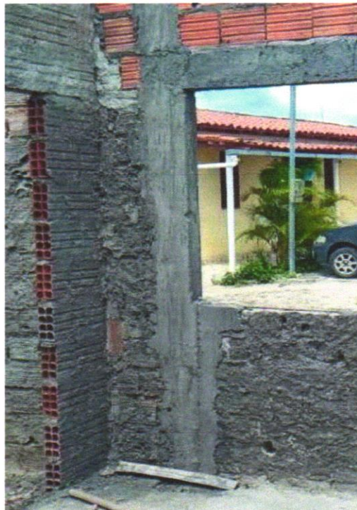
FOTO 04 - (COMPOSIÇÃO REPRESENTATIVA) EXECUÇÃO DE ESTRUTURAS DE CONCRETO ARMADO, PARA EDIFICAÇÃO HABITACIONAL UNIFAMILIAR TÉRREA (CASA EM EMPREENDIMENTOS) FCK=25MPA. AF_01_01/2017
