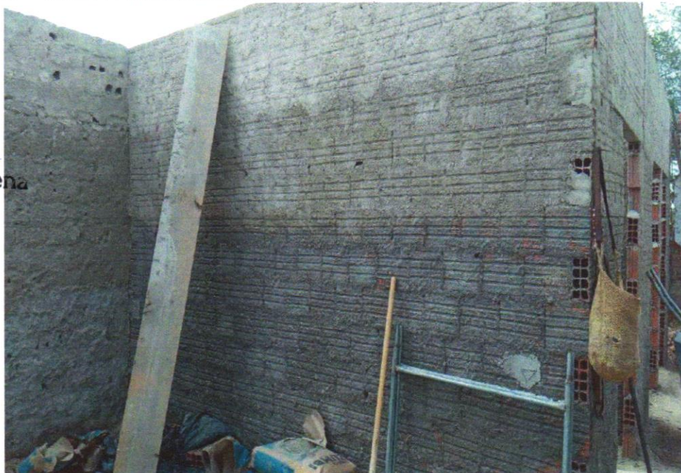
FOTO 10 - CHAPISCO APLICADO EM ALVENARIA (COM PRESENÇA DE VÃOS) E ESTRUTURAS DE CONCRETO DE FACHADA, COM EQUIPAMENTO DE PROJEÇÃO ARGAMASSA TRAÇO 1:3 COM PREPARO EM BETONEIRA 400 L. AF_06/2014
