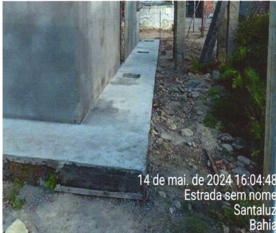
FOTO 17 - Contrapiso em argamassa traço 1:4 (cimento e areia), preparo mecânico com betoneira 400l, aplicado em áreas secas sobre laje, não aderido, acabamento não reforçado, espessura 5cm. Af_07/2021
